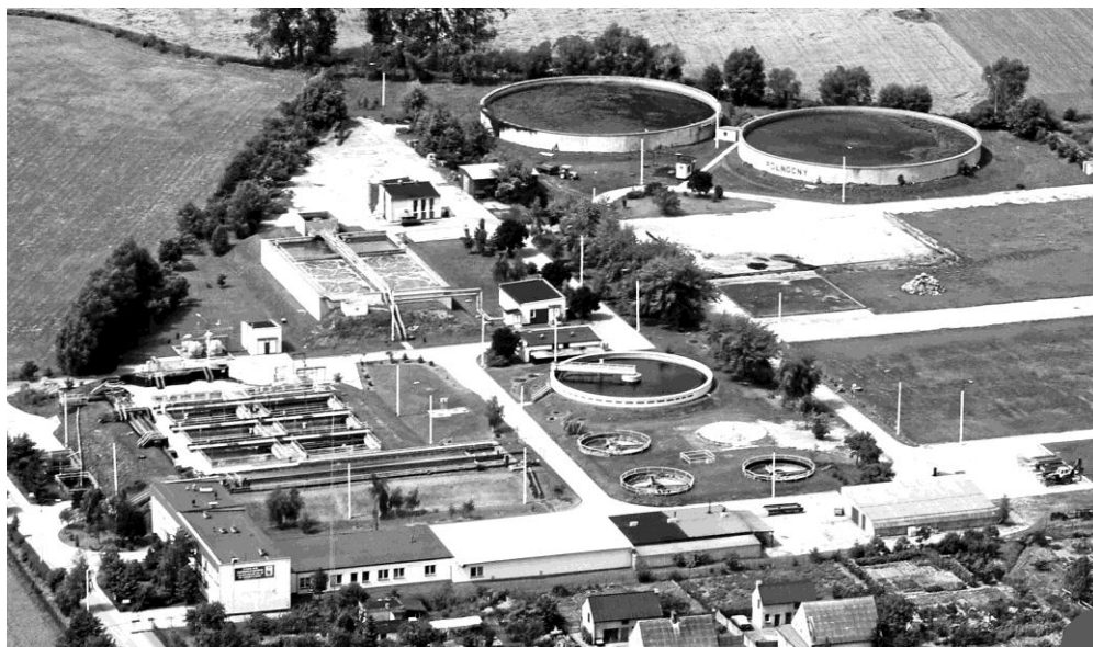
Oczyszczalnia ścieków w Gostyniu
