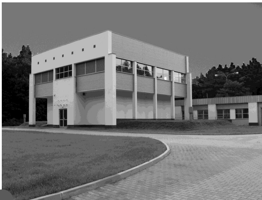
Budynek Stacji Uzdatniania Wody w Gostyniu po modernizacji
