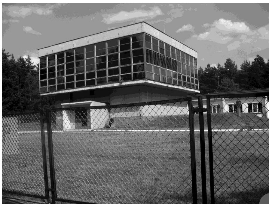
Budynek Stacji Uzdatniania Wody w Gostyniu przed modernizacją
