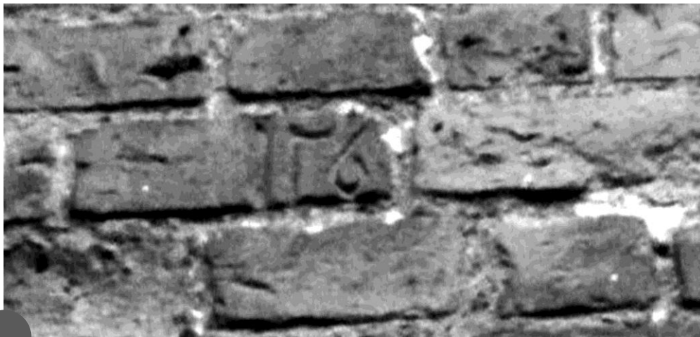
156(?) – odbudowa nawy północnej po katastrofie budowlanej
